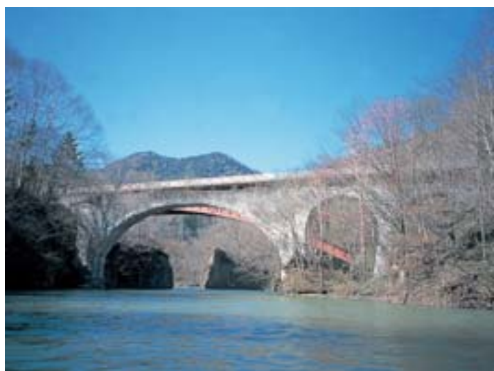
第三音更川橋梁
