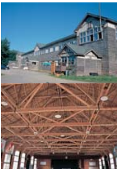
増毛小学校の外観と体育館内部。 体育館の屋根と天井は三角形を基本とした木造トラスで組まれている
