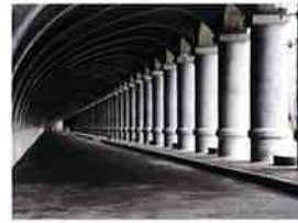
稚内港北防波堤ドーム
