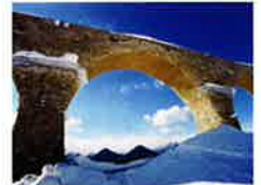
旧国鉄士幌線 コンクリートアーチ橋梁群
