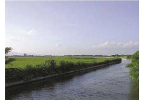
赤平市から南幌町（7市町）まで延長約80kmにおよぶ北海幹線用水路は、農業専用では日本で最も長い。空知平野の農地に水を供給するために造られ、北海道の穀倉を支える役割を果たしている。大正13年から4年で完成し、空知川から最大毎秒44tを取水。北海頭首工を起点に、美唄市には調整池が、砂川、美唄、岩見沢市市街地では親水公園が整備されている。
