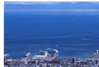
「港湾工学の父」廣井勇により建設された北防波堤は、セイロン（現スリランカ）のコロンボ港防波堤を参考にし、独特の傾斜ブロック工法を採用した日本初の外洋防波堤。ケーソン工法を取り入れた島防波堤とともに、今も現役で機能している。防波堤に守られた小樽のみなとは北海道移住の玄関口となり、また物流拠点、貿易港として、商都・小樽の繁栄を支えている。
