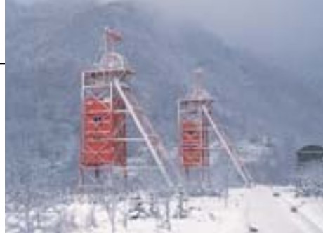
三菱美唄炭鉱立坑巻揚槽
