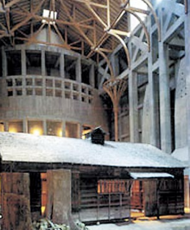
上湧別町のJRYに移築保存されている屯田兵屋
