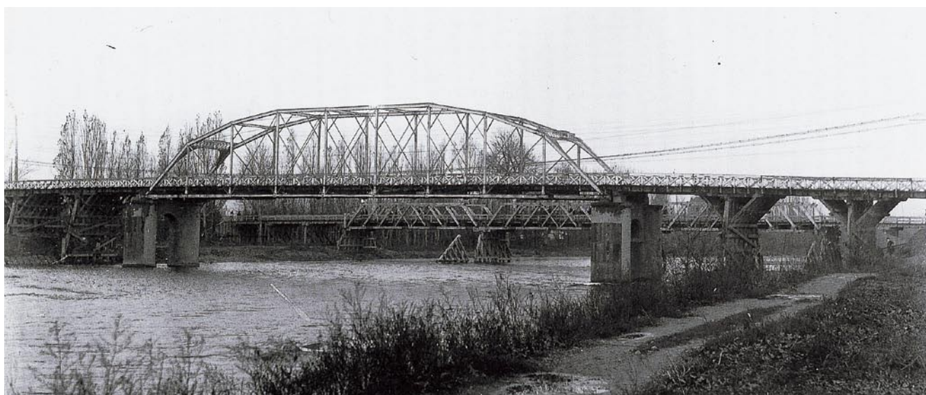
初代旭橋。昭和7年に深川市の納内橋として再生され、昭和40年まで使用された。（写真は「旭橋60周年記念誌」より）
