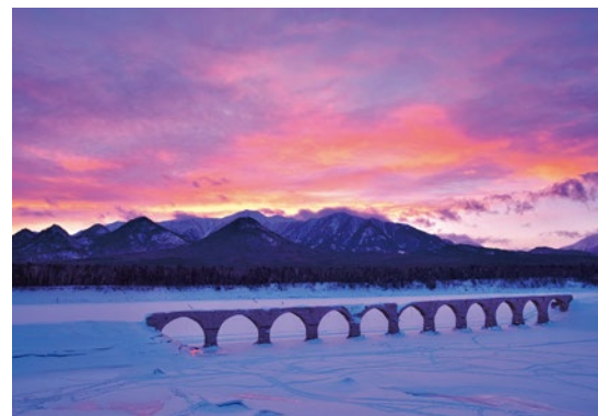
夕暮れ色に染まる【撮影/上土幌町・タウシュベツ川橋梁 2019年1月】 旧国鉄土幌線コンクリートアーチ橋梁群
